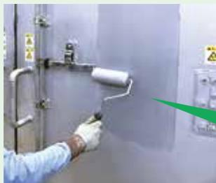
乾燥炉への断熱塗料塗布
