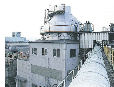
中空メルマリット製造工場(外観)
