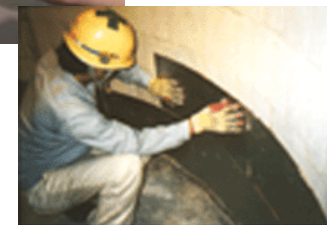
鉄鋼業(溶鋼鍋)での施工例
