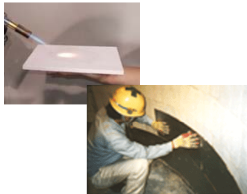
鉄鋼業(溶鋼鍋)での施工例
