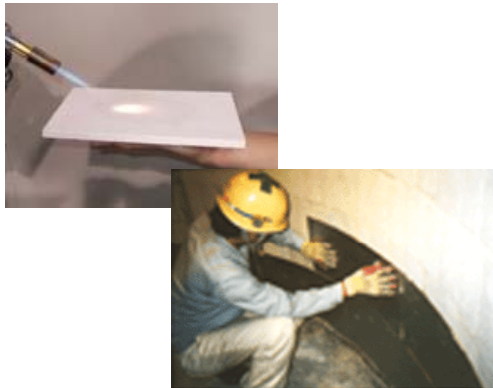
鉄鋼業(溶鋼鍋)での施工例
