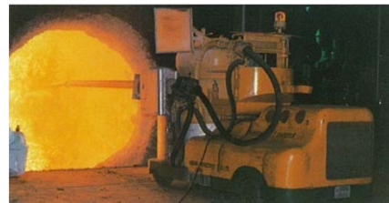
転炉吹付用不定形耐火物 ※写真は吹付けの様子
