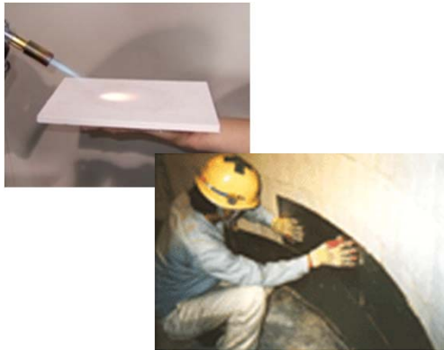
鉄鋼業(溶鋼鍋)での施工例
