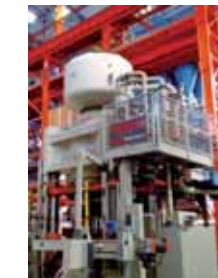
増設設備（一部）
