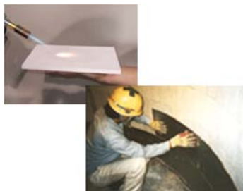
鉄鋼業(溶鋼鍋)での施工例
