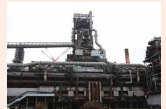
改修後の戸畑第4高炉 (提供:新日鐵住金株式会社殿)
