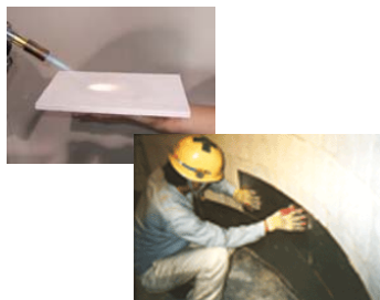
鉄鋼業(溶鋼鍋)での施工例
