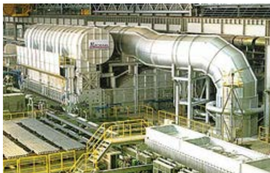
施工例)プッシャー式ピレット連続式圧延加熱炉
