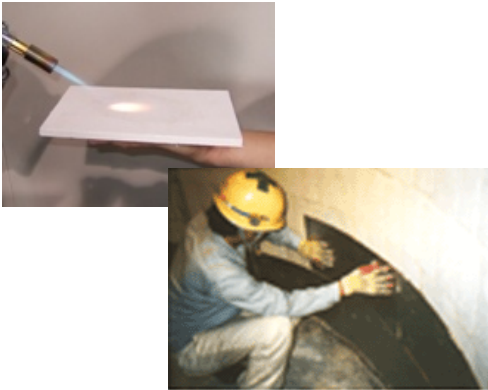
鉄鋼業(溶鋼鍋)での施工例
