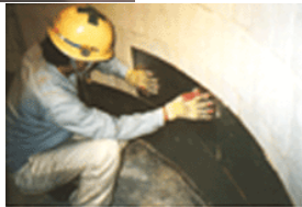
鉄鋼業(溶鋼鍋)での施工例
