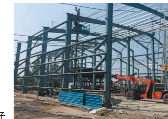
マッド工場建屋建設の様子
