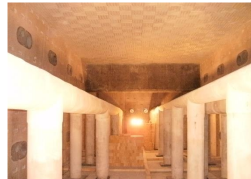
加熱炉内での耐火物施工
