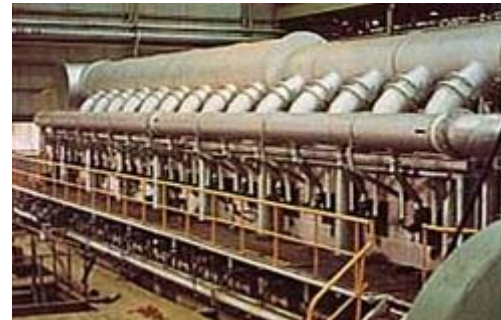
ウォーキングビーム炉(加熱炉)の外観
