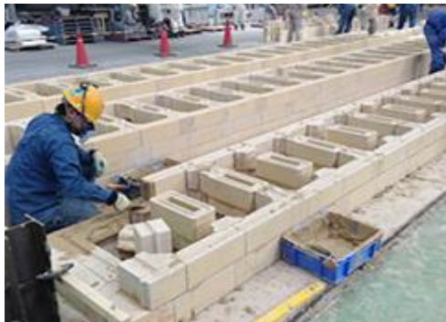
コークス炉の耐火物施工
