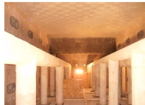
加熱炉内での耐火物施工
