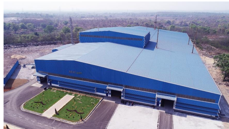
新たに竣工したAG工場
