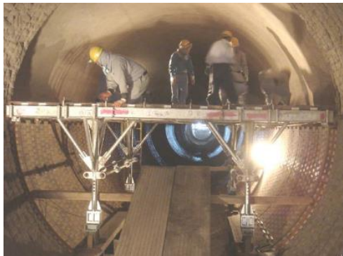
セメントロータリーキルン内での耐火物施工の様子
