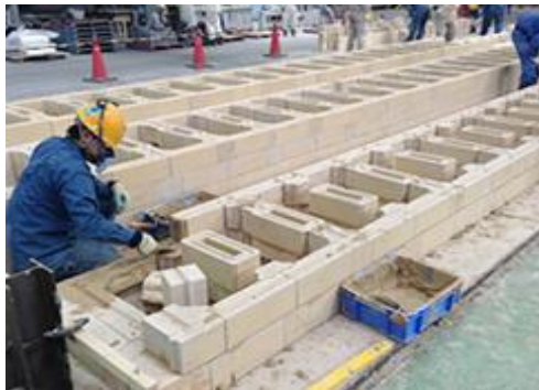
コークス炉の耐火物施工
