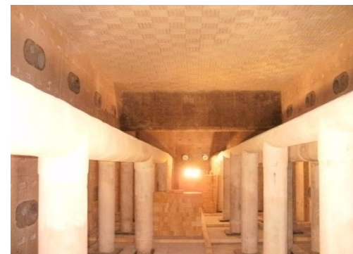
加熱炉内での耐火物施工
