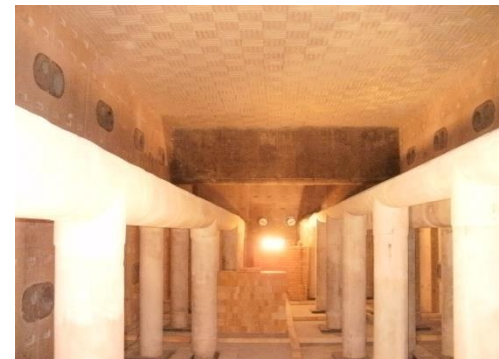
加熱炉内での耐火物施工
