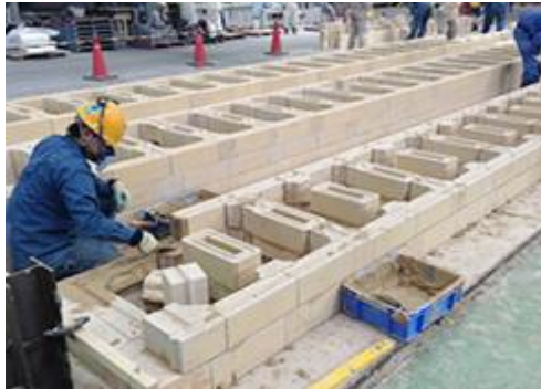
コークス炉の耐火物施工
