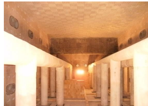
加熱炉内での耐火物施工
