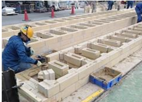
コークス炉の耐火物施工
