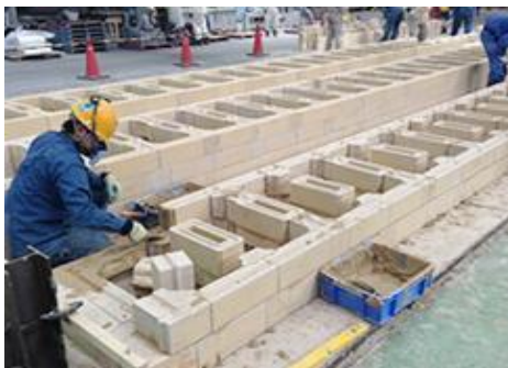
コークス炉の耐火物施工
