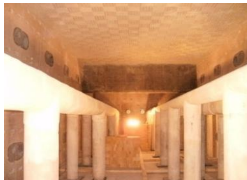
加熱炉内での耐火物施工
