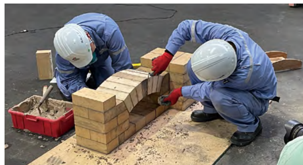
築炉技能検定(国家資格)練習を通じた技能伝承
